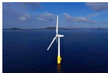
浮体式洋上風力発電 出典：戸田建設
