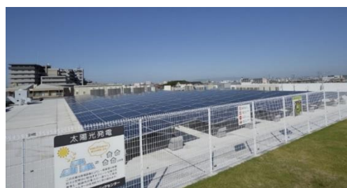
イオン藤井寺屋上の太陽光発電設備： 出典：日経 BP
