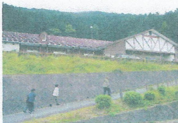
わらびの里 外観
