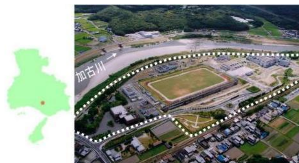
写真11 加古川上流浄化センター
