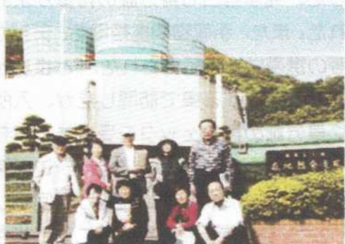
▲北電が所有する森町の地熱発電所
