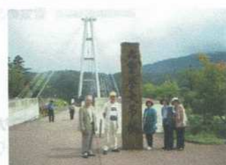
九重夢大吊橋
